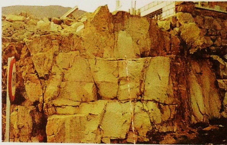
Granito. Calidad buena. Varias familias de discontinuidades alteradas.
